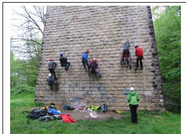
Viaduc de Charbonnière, 69 (BL, 30/04/2016)
