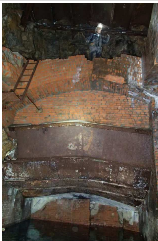
Le puits en briques (BL, 31/01/2016)
